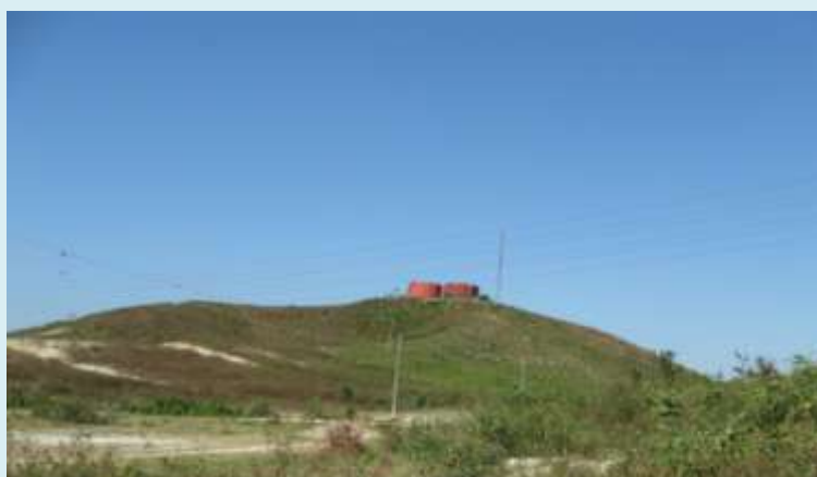
Tanques de almacenamiento de agua potable con alta capacidad serán construidos con financiamiento del PROMOSAS en varios municipios del país.
