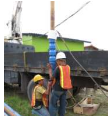
Instalación de bomba en pozo.
